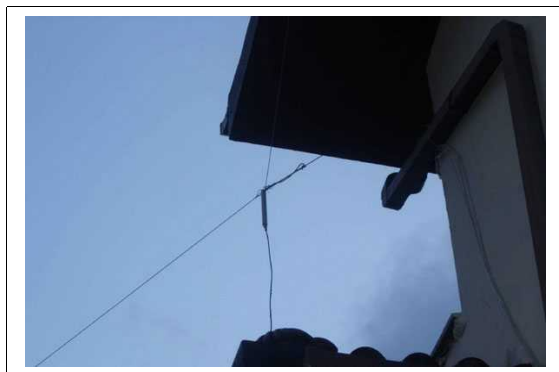
la filare sul tetto
