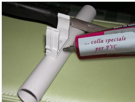
Fig. 4 - con la colla per PVC si uniscono le due parti
