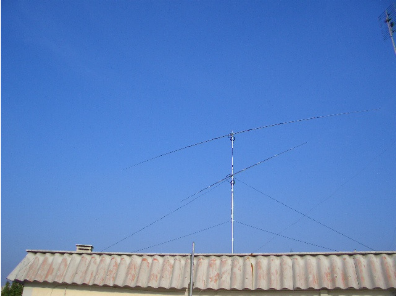
Installazione del dipolo per 21 MHz sotto il dipolo per 14 MHz
