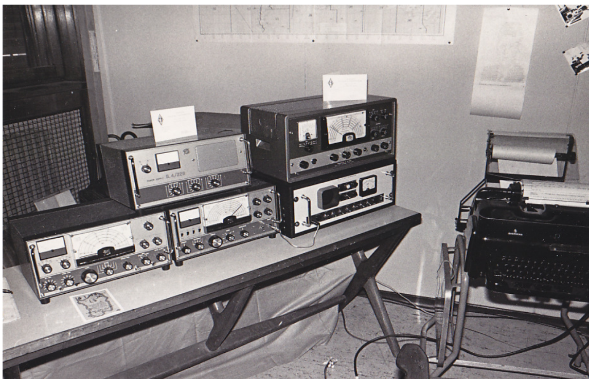
Nella foto 7: da sinistra in basso Tx G 4/228, Rx G4/216, decoder RTTY, a fianco TTY Siemens, sopra alimentatore G4/229, RX G4/215 (per la stazione RTTY)
